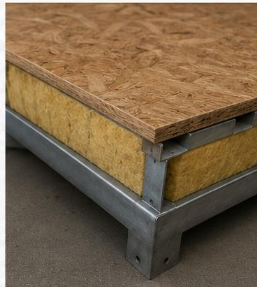
2. TOPLINSKA IZOLACIJA I OSB PODLOGA
