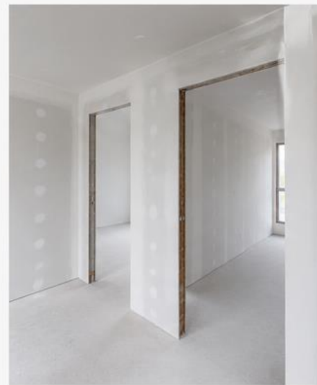
1. KNAUF BOARDS - MAIN LAYER
