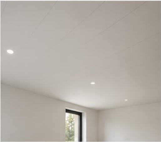
3. INTERNAL KNAUF LINING
